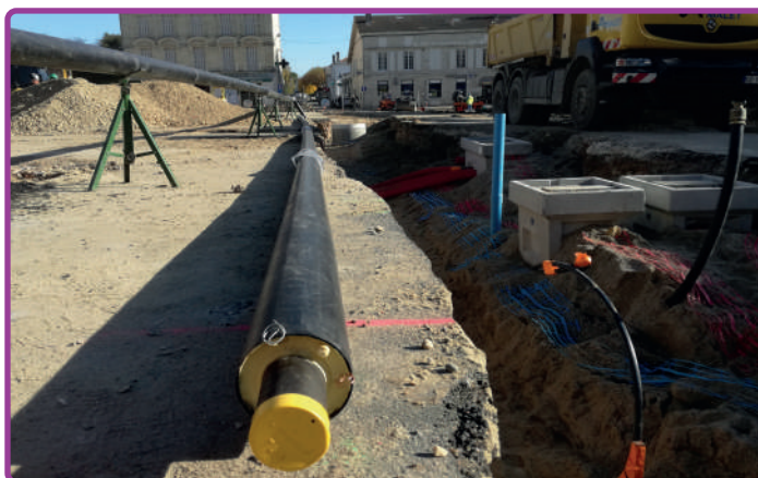
Installation du réseau de chaleur à Aiguillon
