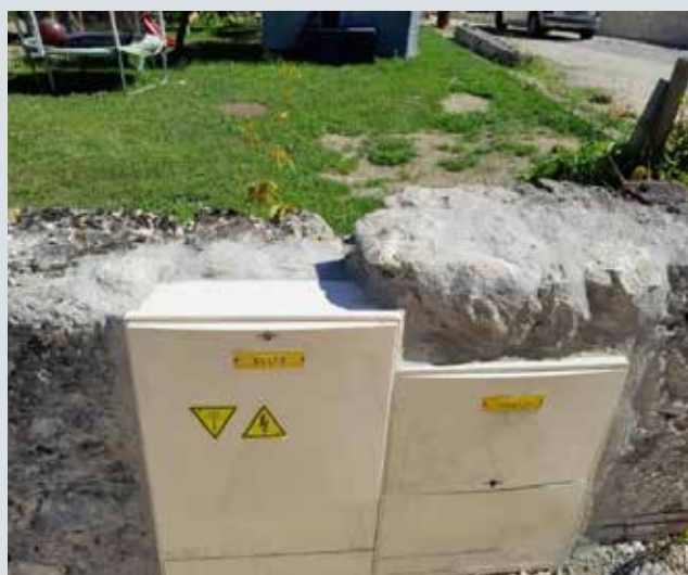
Encastrement de coffret de réseau électrique
