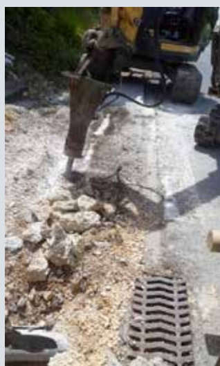
Démolition au BRH
