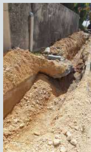
Tranchée technique réalisée
